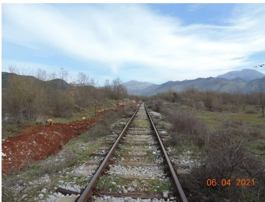
Figure 2.18_Pamje nga segmenti prej km 132+620 ne km 133+370; Hekurudha kalon permesh shkurresh, kullotash dhe pyjesh
